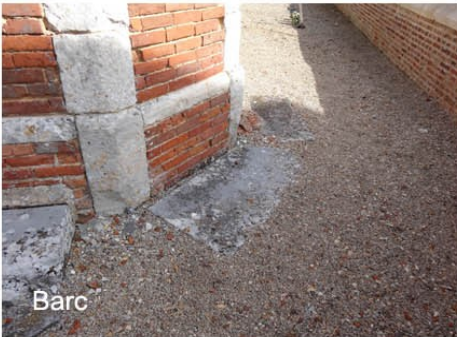
au pieds des murs extérieures
